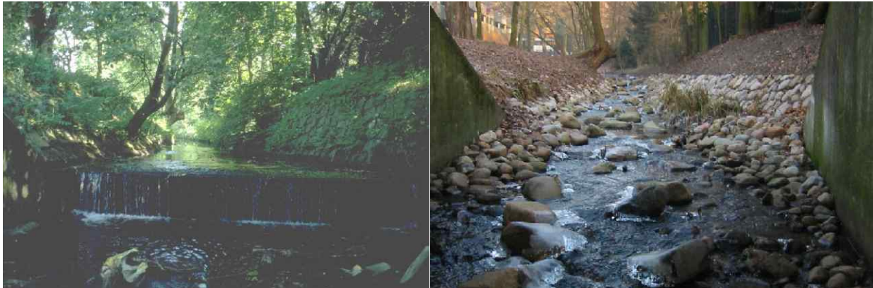
Rysunek 6a / b: Amtsstraße, Rahlstedt, przed i po przebudowie.
