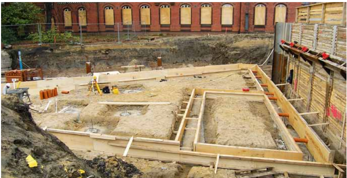
Einbau der horizontalen Flächendrainage und der Fundamentdurchbrüche
