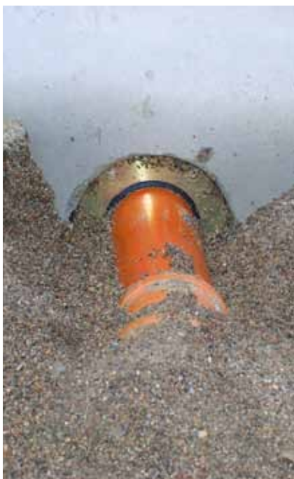
Gasdichte Leitungsdurchführung
