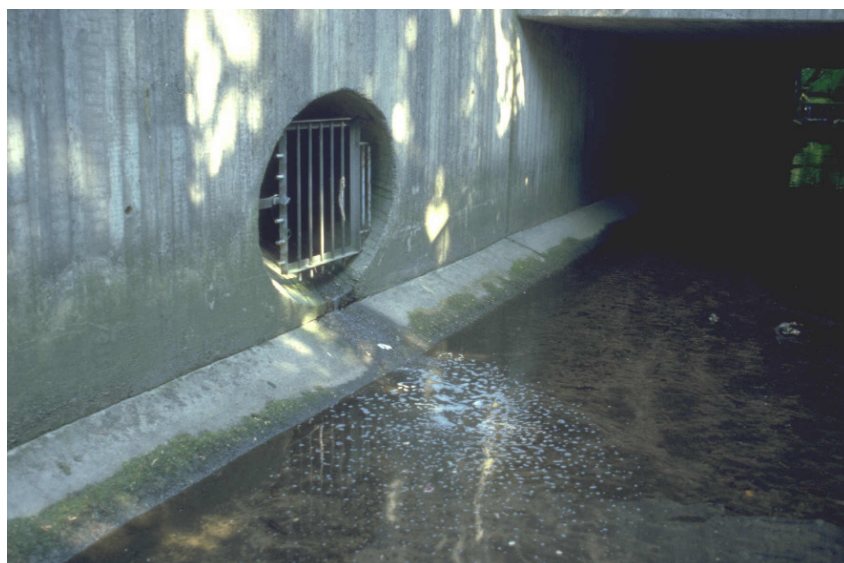
Obr. 8: Veškerý odpad, který je vyléván do uličních vpustí, může být při nízkých průtocích velmi nebezpečný. Průměr odpadního potrubí vypovídá o množství vody, které je při silných deštích zaústěno do vodotečí.
