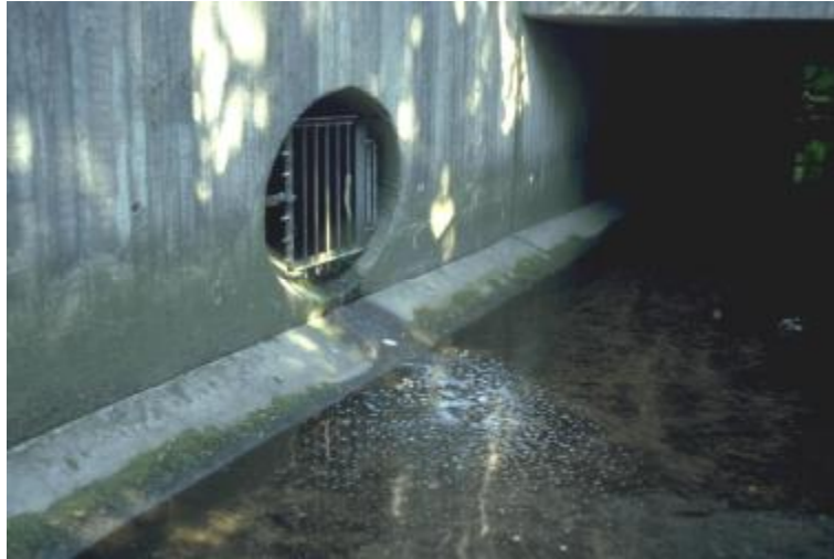
Bild 8: Uthållt städvatten har i lågvattensituationer omedelbar skadeverkan. Diametern på tillloppsroret ger en föräning om den hydrologiska situationen vid kraftigt nedfall.
