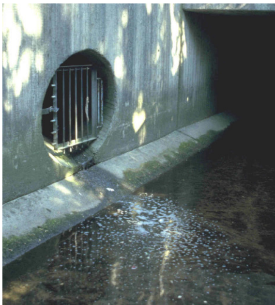
Фото 8. Мыльная вода после уборки несёт непосредственный ущерб при пониженном уровне воды. По диаметру водосточной трубы можно предположить, что происходит с гидравлической ситуацией, в случае сильного дождя
