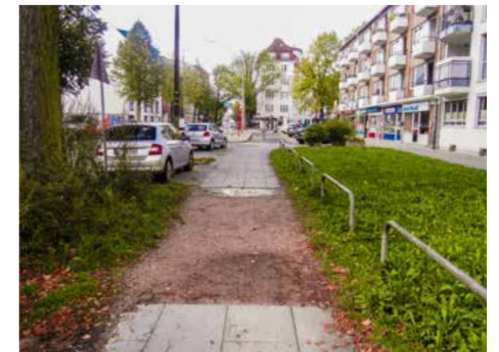
Die Nebenflächen werden barrierefrei hergestellt und für Radfahrer werden zukünftig Radfahrstreifen auf der Fahrbahn vorgesehen
