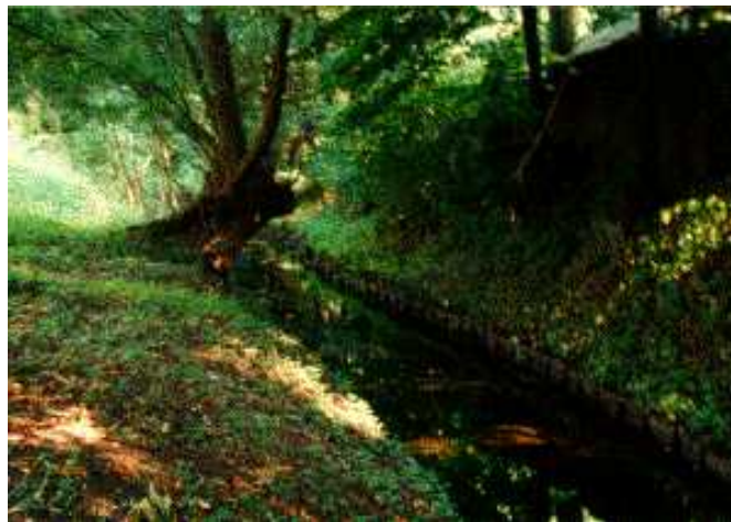
Uferbefestigung aus Bongossiholz
