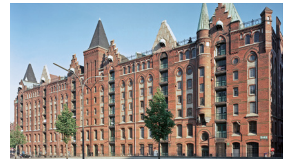
Der Brooktorkai stellt den südöstlichen Abschnitt der Speicherstadt dar.
