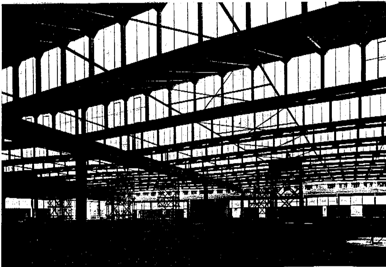
Die Stahldachkonstruktion mit den Lichtbändern
