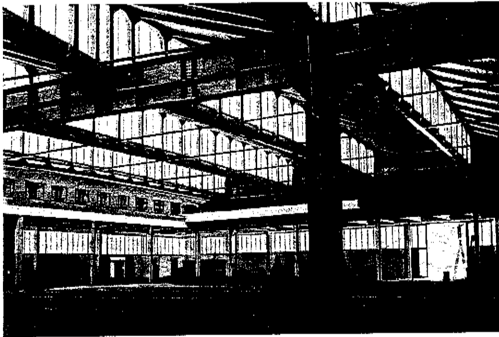
Das Innere der Halle mit einer der vier Säulen der Stahldachkonstruktion (Träger versenkt)
