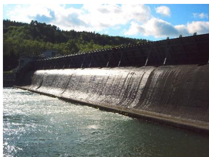
Abbildung 7: Wasserkraftwerk, von thomas springer - Eigenes Werk, Gemeinfrei, https://commons.wikimedia.org/w/index.php?curid=812520
