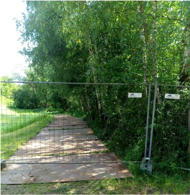
Abb. 2: Ausgelegte Bodenplatten
