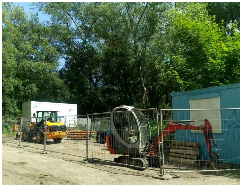
Abb. 1: Baustelleneinrichtung am Parkplatz Walter-Hammer-Weg
