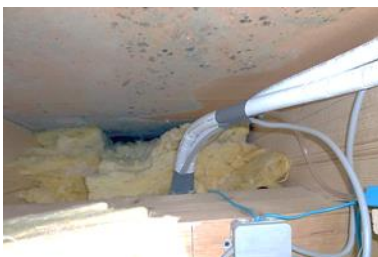
Abbildung 21: Von Energiesorgenfrei (Diskussion) - http://schimmelbutze.de/dachboden/ , CC BY-SA 3.0 de, https://commons.wikimedia.org/w/index.php?curid=41234805
