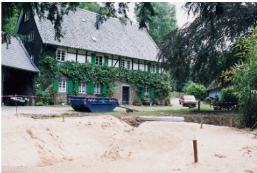
Abbildung 4-5 Lamberts-mühle in Burscheid mit im Bau befindlicher Pflanzenkläranlage im Vordergrund
