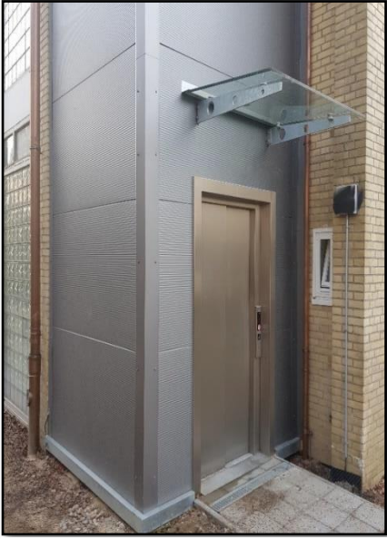
Realisierungsbeispiel: Ergänzter Außenaufzug am Heilwig-Gymnasium.
