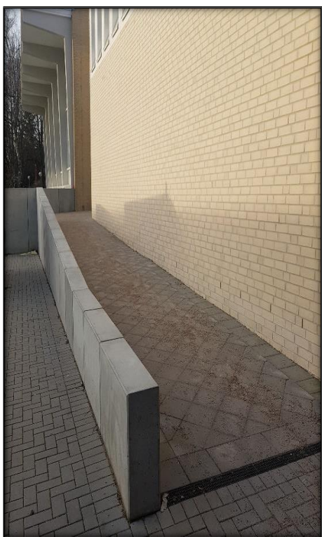
Realisierungsbeispiel: Rampe zur barrierefreien Erschließung von Neu- und Altbau des Heilwig-Gymnasiums.
