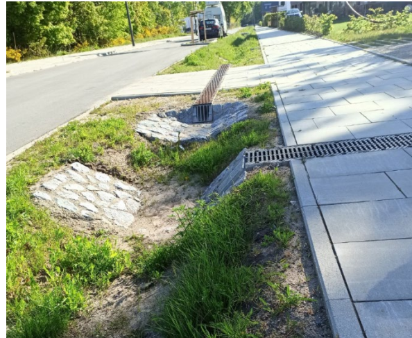
Offene Entwässerung mit Gräben
