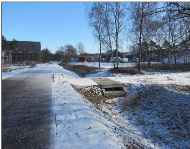
Kaskadierendes System mit Sickergraben
