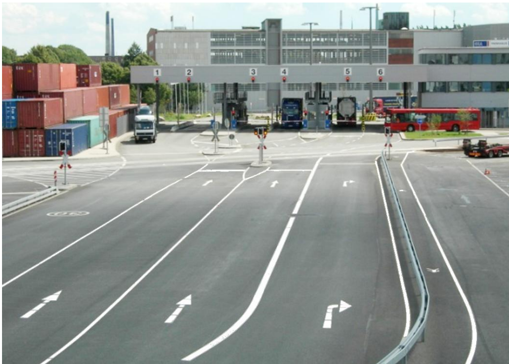
Beispiele für übersichtliche Verkehrsführung: Leitplanken trennen innerbetrieblichen und Zulieferverkehr
