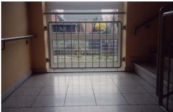
Geländer vor Verglasung
