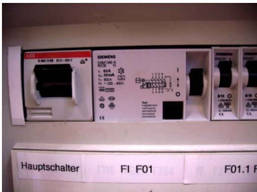
RCD-Schalter (Fehlerstromschutzschalter)
