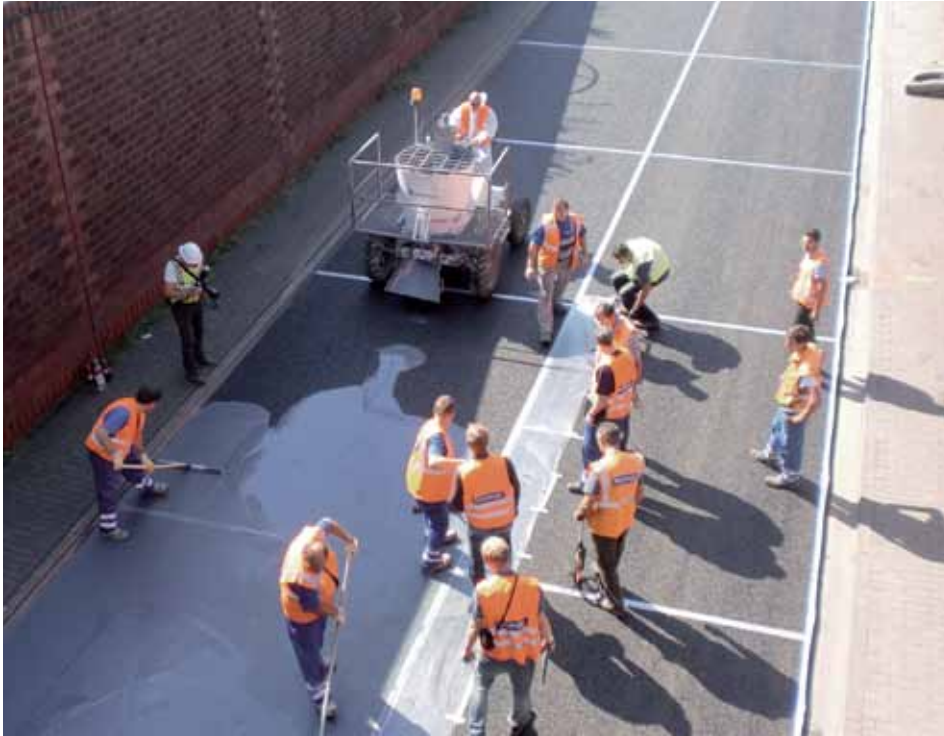
Experten errichten Teststrecke am Krohnstiegtunnel
