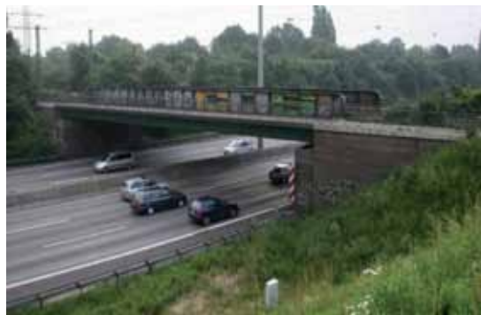
Muss verbreitert werden: Die Brücke der Güterumgehungsbahn
