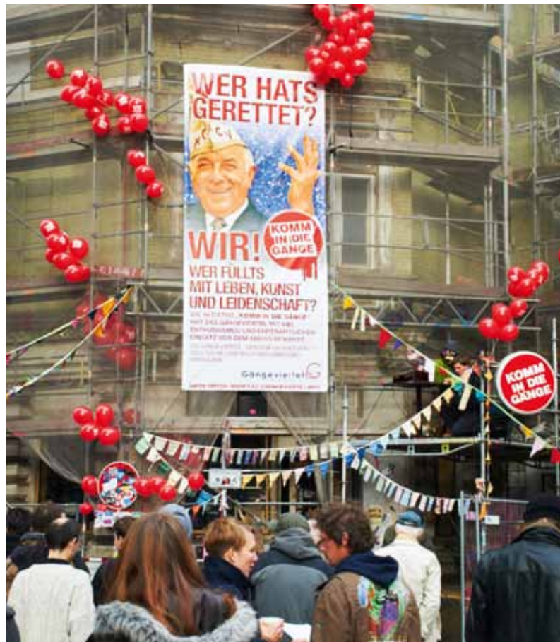
Aktive aus dem Gängeviertel feiern den Baubeginn – Foto: Franziska Holz, 2013
