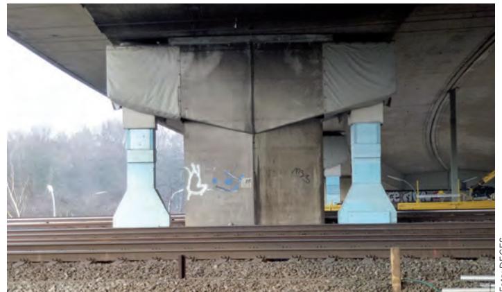
Abb.: zusätzliche Stützenverstärkung der Langenfelder Brücke
