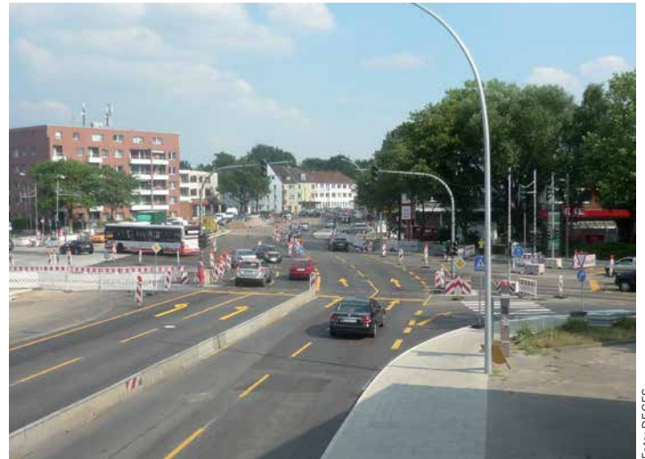
Abb.: Stand der Arbeiten 17. Juli 2014
