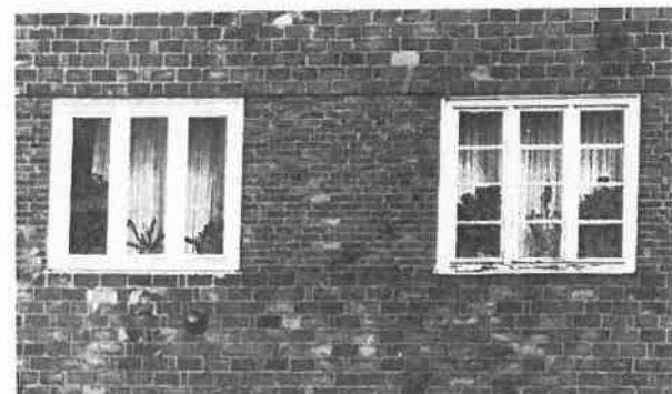
erneuerte und ursprüngliche Fensterform
