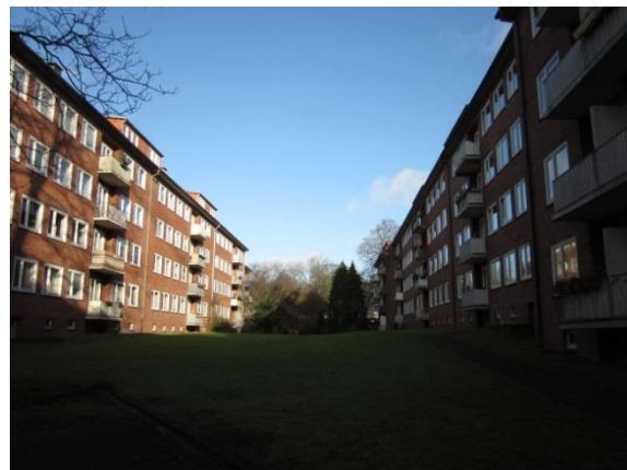
12 1950er Jahre Maria-Louisen-Stieg, Fassaden zur Freifläche
