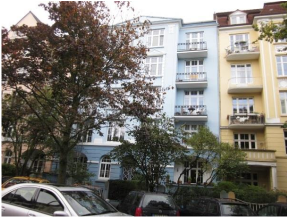
1 Gründerzeitliche Etagenhäuser Eppendorfer Stieg
