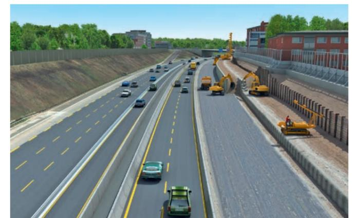
Abb. 4: Verlegung der Fahrstreifen in Richtung Hannover auf die Fahrbahn gen Norden.
