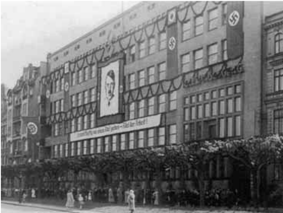
Hauptverwaltung der Volksfürsorge Lebensversicherung An der Alster in den 1930er Jahren.
