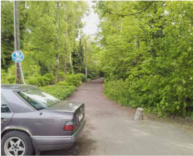
Im Bereich zwischen den Kleingärten und Spannskamp wird der vorhandene Weg verbreitert und mit Asphalt befestigt.
