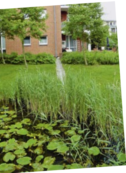
Offene Oberflächenentwässerung im Wohngebiet „Trabrennbahn Farmsen“.
