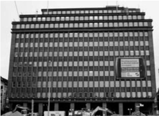
Verbandshaus des „Deutschnationalen Handlungsgehilfen-Verbands“ am Johannes-Brahms-Platz, errichtet 1929–1931. Heutiger Name „Brahms Kontor“.
