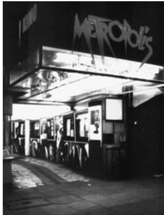
Eingang zum „Metropolis“. Für den Bau der Opernpassage wurde das Kino abgerissen und die Inneneinrichtung bis zur Fertigstellung des neuen Büro- und Geschäftshauses „Metropolis Haus“, in das das Kino integriert werden soll, eingelagert. STAATSARCHIV HAMBURG
