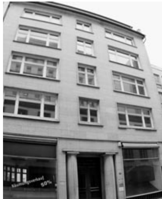
Große Theaterstraße 32. In diesem Haus bot der Inhaber der dortigen „Buchhandlung an der Staatsoper“ in den 60er Jahren des 20. Jh. ein Sortiment homosexueller Belletristik an. Das Haus soll 2010/2011 abgerissen werden (Stand: Oktober 2010). PHOTO: MARINA BRUSE
