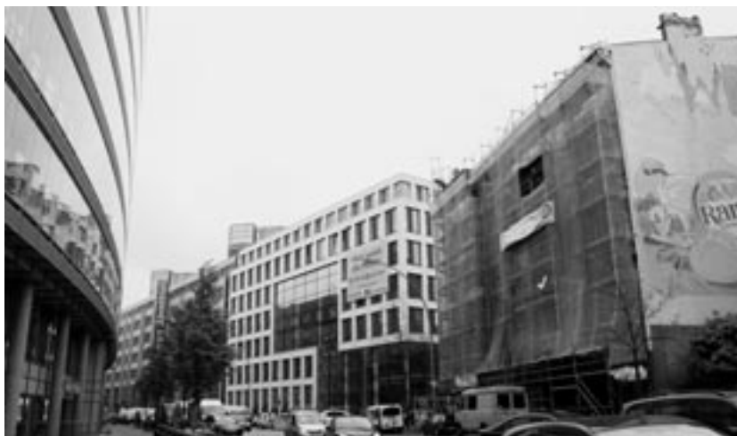
Blick vom Valentinskamp in die Caffamacherreihe in Richtung Axel-Springer-Passage. So sieht heute der Teil der Caffamacherreihe aus, in dem es zu Beginn des 20. Jh. viele Arbeiterkneipen gab, in denen über Politik und das Weltgeschehen diskutiert wurde.
