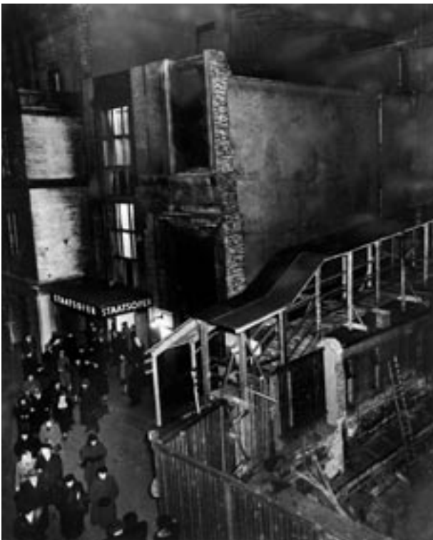
Seiteneingang fürs Publikum in das von 1946 bis 1955 existierende Opern-Provisorium. 1943 waren das Zuschauerhaus und einige Nebengebäude der Staatsoper durch Bomben zerstört worden.
