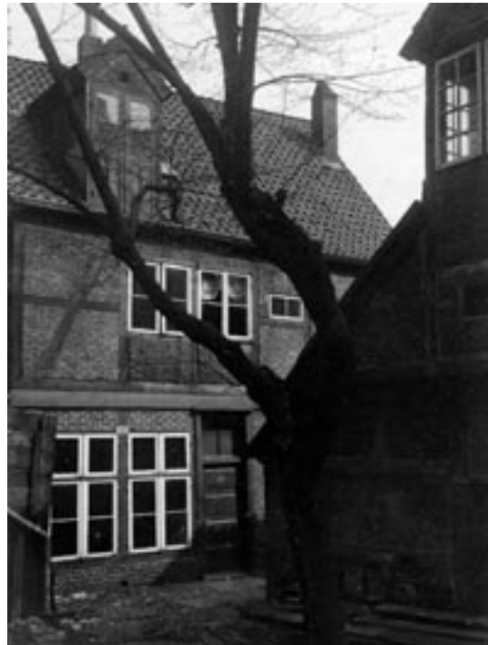
Hof Drehbahn 36, 1913, Abriss 1913.
