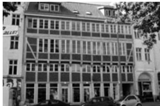
Das Fachwerkhhaus Valentinskamp 34 ist eines der ältesten erhaltenen profanen Baudenkmale in Hamburg, erbaut 1634/1650. PHOTO: JÜRGEN BRÖMME
