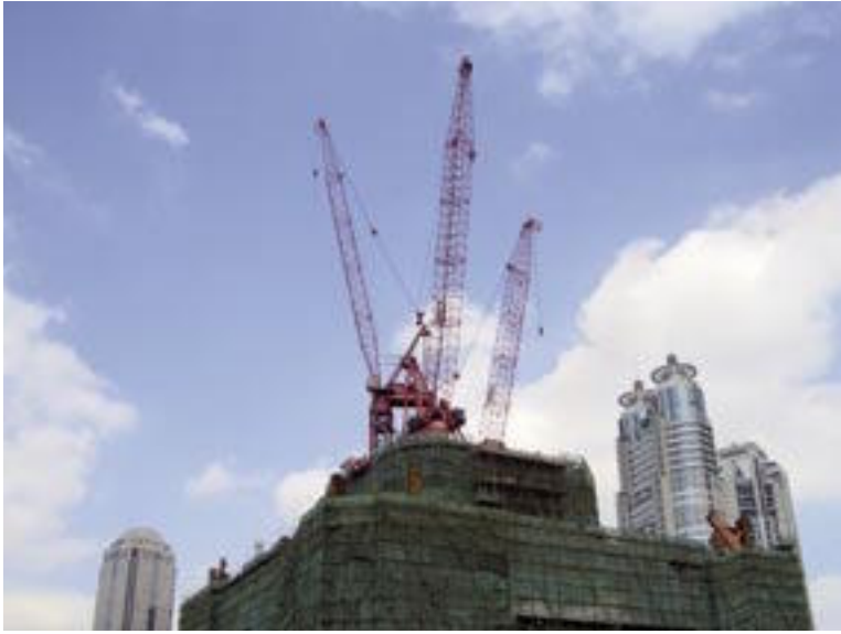
Baustelle des Shanghai World Financial Centers in Pudong Foto: F.W.
