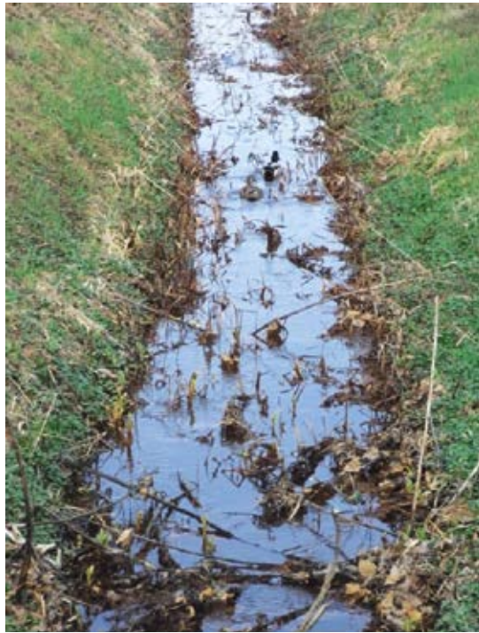
Akzeptanz von Krautentwicklungen im Profil bei ausreichendem hydraulischen Puffer
