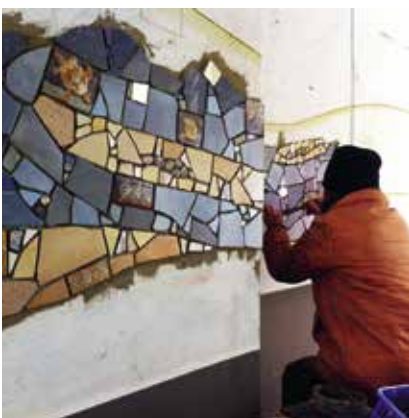
Keramikwerkstatt für die Hofdurchgänge im Steilshooper Wohnring 6.
