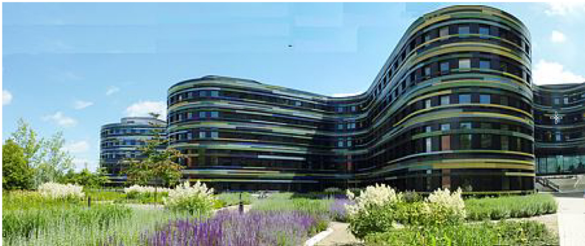
Abbildung 1 Bepflanzte Grünflächen zur Versickerung von Niederschlagswasser
