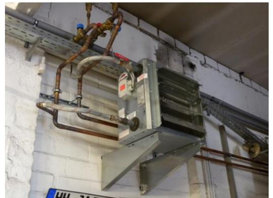
Neben der Installation von modulierenden Gas-Brennwertkesseln wurde die komplette Heizungsanlage des Werkstattgebäudes durch Warmluftheizer mit einer Systemtemperatur von 50/30 °C ersetzt. Einzelregelungen für die Arbeitsplätze, Magnetventile in den Vorlaufleitungen und die Dämmung der Rohrleitungen in der Halle sorgen für eine effiziente Wärmeverteilung und Ausnutzung des Brennwerteffektes.
