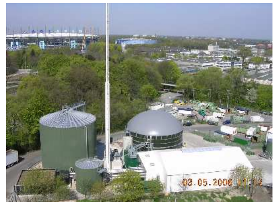
Biogasanlage Stelling Moor der BIOWERK Hamburg GmbH & Co. KG
