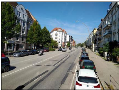
Abbildung 4: schlechter Fahrbahnzustand Lokstedter Weg (Nord) (Quelle: IVAS)
