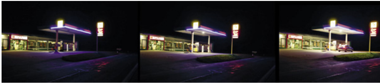
Abb. 14.: Bedarfsgesteuerte Beleuchtung einer Tankstelle. Erst wenn sich Fahrzeuge der Tankstelle nähern, wird die Lichtstärke erhöht. Foto: Andreas Hänel
