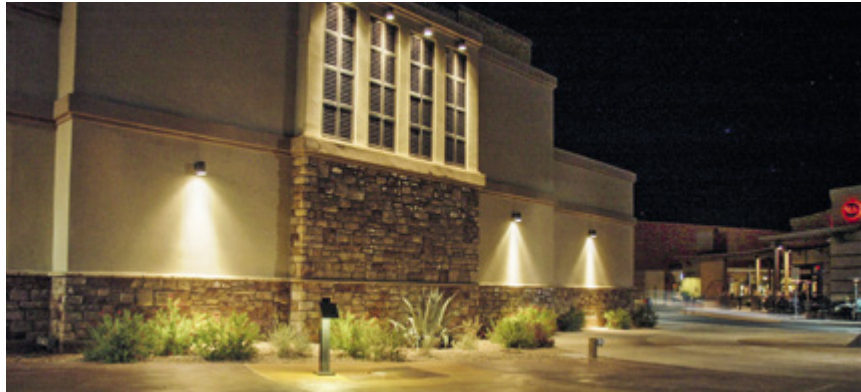
Abb. A11: Außenbeleuchtung eines Gebäudes in Tucson, Arizona. Foto: International Dark Sky Association (IDA)
