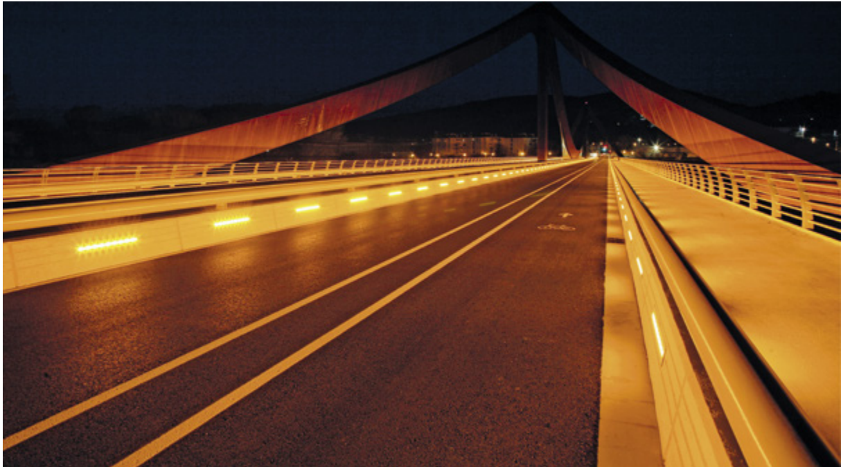
Abb. A3: Brückenbeleuchtung im naturschutzfachlich sensiblen Gebiet über den Fluss Ter. Foto: Ignialight
