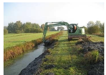
Grabenräumung in den Kirchwerder Wiesen
