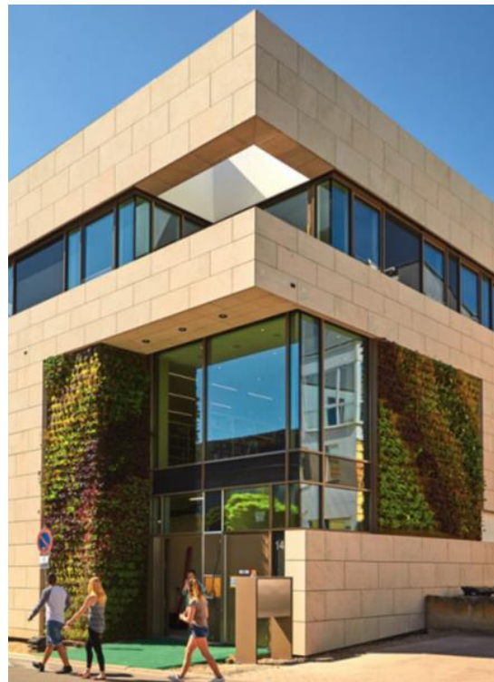
Abbildung 12: kassettenförmige Wandbegrünung (Foto: © Vertiko GmbH)
