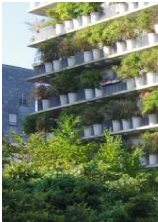
Abbildung 8: geschossweise eise Brandsperren (Foto: © Nicole Pfoser)
