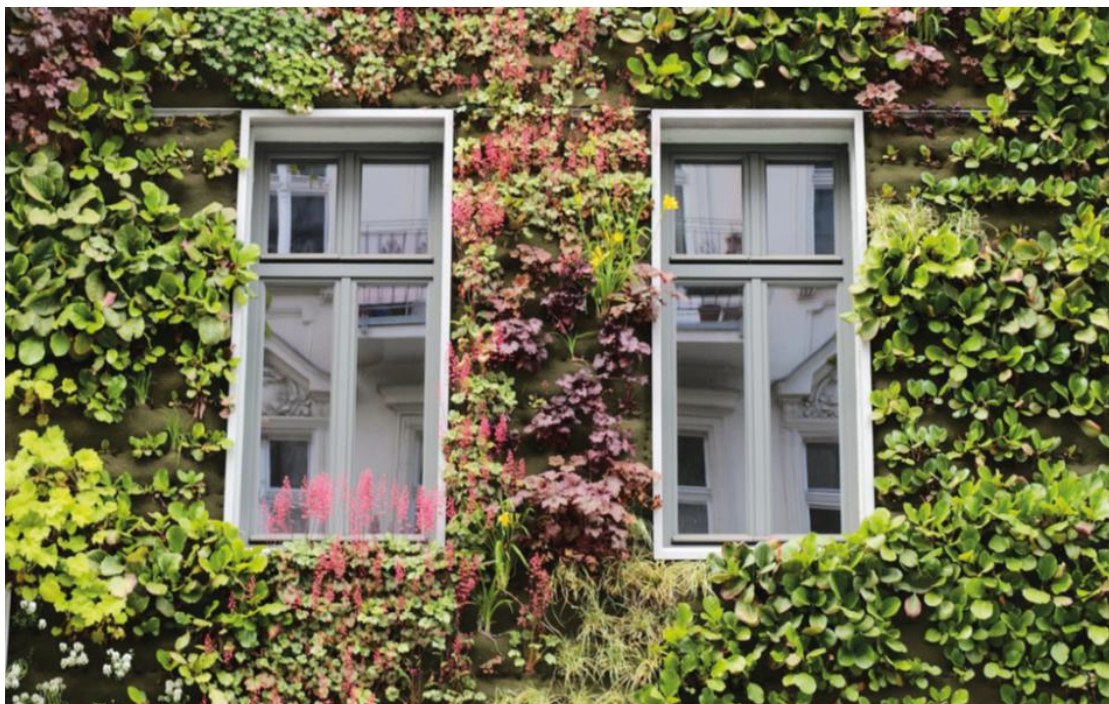
Abbildung 6: Schutz der Fensteröffnungen durch auskragende Bleche (Foto: © Vertiko GmbH)
