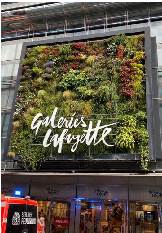
Abbildung 11: kassettenförmige Wandbegrünung (Foto: BSW)
