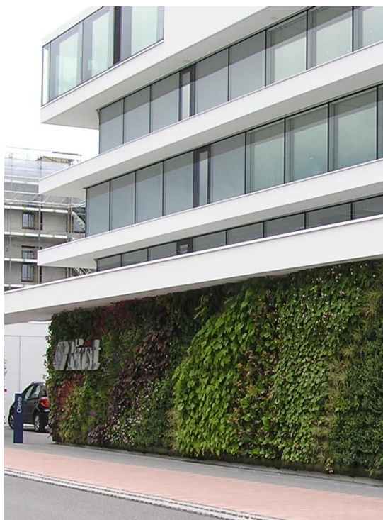
Abbildung 9: auskragendes Bauteil als Brandsperre (Foto: © Vertiko GmbH)
