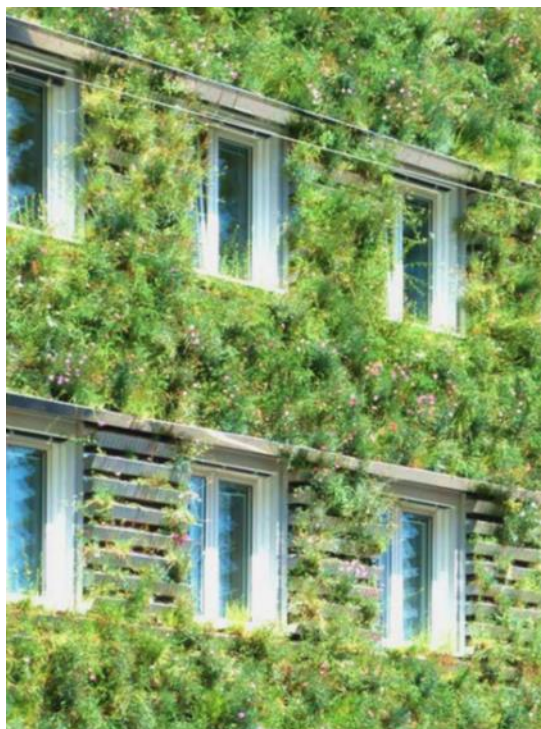
Abbildung 7: geschossweise eise Brandsperren (Foto: © Nicole Pfoser)
