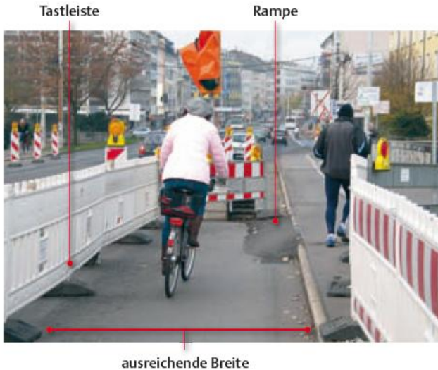
Abb. Sinnvolle Elemente einer barrierefreien Baustelle 1iii
