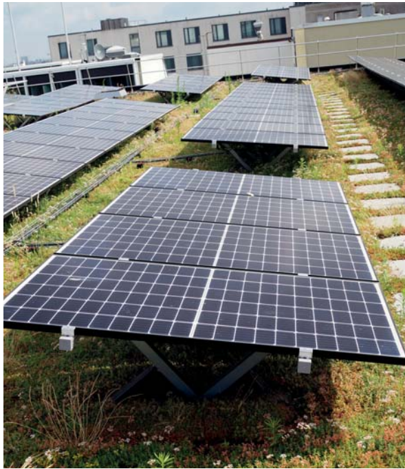
Bild 6: Solargründach in der Hamburger Innenstadt. © BUKEA/ Lukas Kühle
