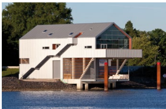
Die Mügge – von außen bereits zu bewundern, derzeit läuft der Innenausbau
