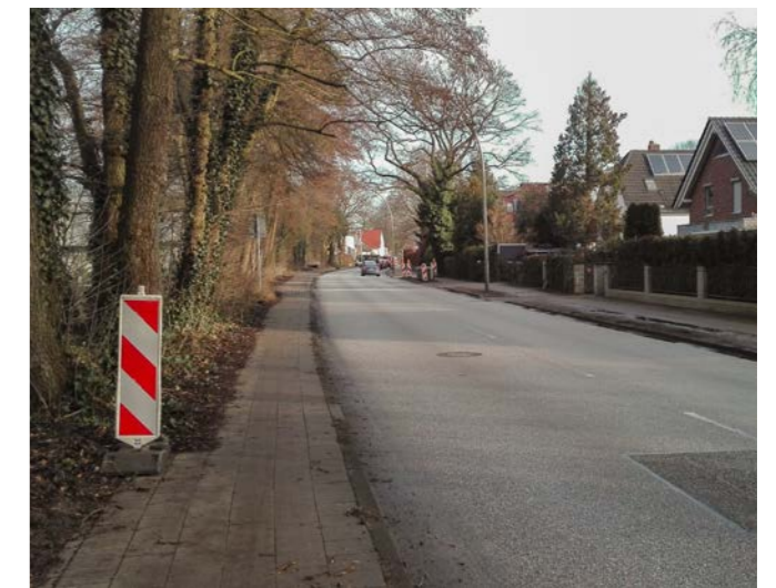
Nördlich der Güterumgehungsbahn sind keine Radverkehrsanlagen vorhanden
