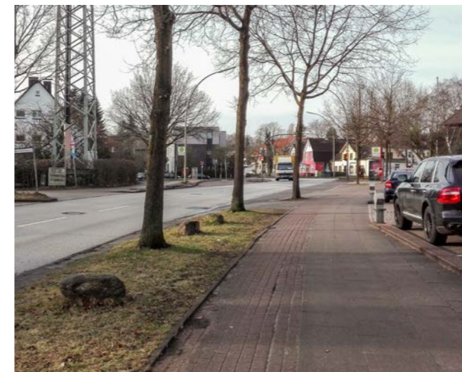
Die Rad- und Gehwege sind zu schmal, wodurch die Barrierefreiheit nicht gegeben ist
