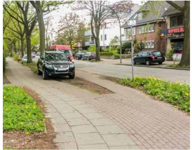
Die Radverkehrsanlagen in der Stresemannallee entsprechen nicht einer modernen Infrastruktur.
