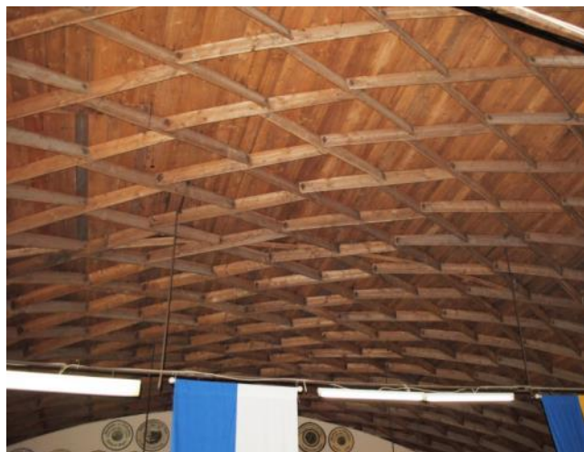
Abbildung 10: Schützenhalle in Salzgitter-Lesse, Baujahr 1927 (Konstruktion als Tonnendach ohne First)
