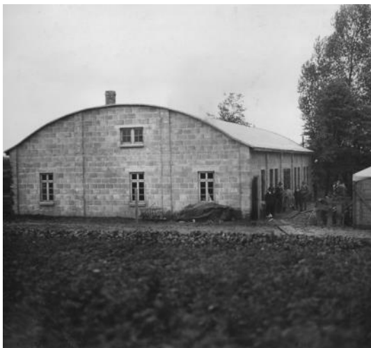
Abbildung 10: Schützenhalle in Salzgitter-Lesse, Baujahr 1927 (Konstruktion als Tonnendach ohne First)
