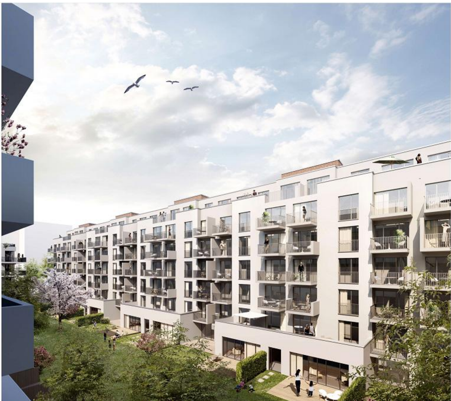
Blick auf die Rückseite des Gebäudes an der Sonninstraße
