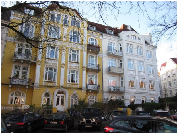
Etagenhäuser, Erikastraße 105 / Siemssenstraße 1
