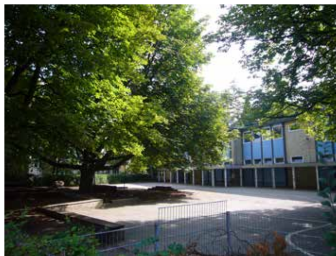
Grundschule St. Nikolai, Außenanlagen
