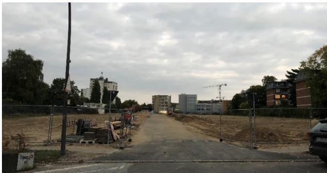
Baustraße Mesterkamp im Oktober 2022 (Quelle: Bezirksamt Hamburg-Nord)
