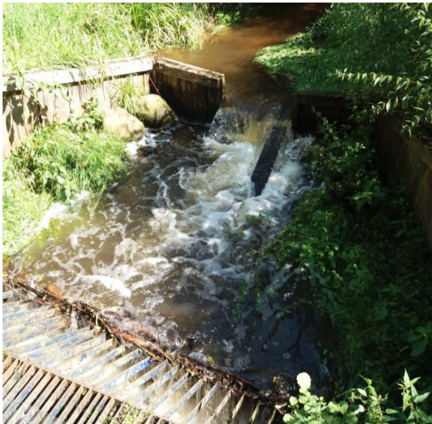
Abbildung 11 Auslaufbauwerk im Verlauf der Stellau
