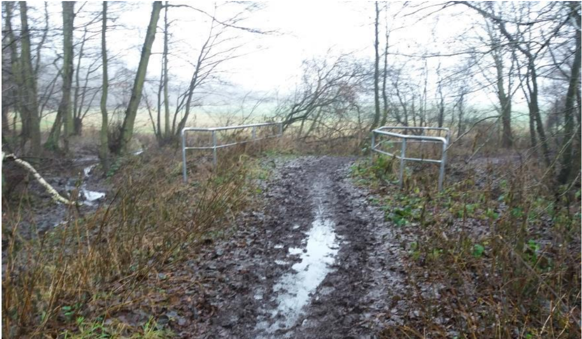
Abbildung 5 Kösterrodenweg/ Brücke über die Stellau
